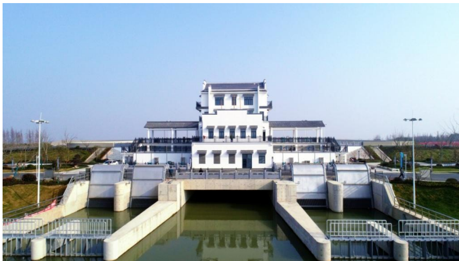
崇明区横沙红星河整治及反帝圩泵闸新建工程 胡晨凯 2021 年 12 月 14 日
