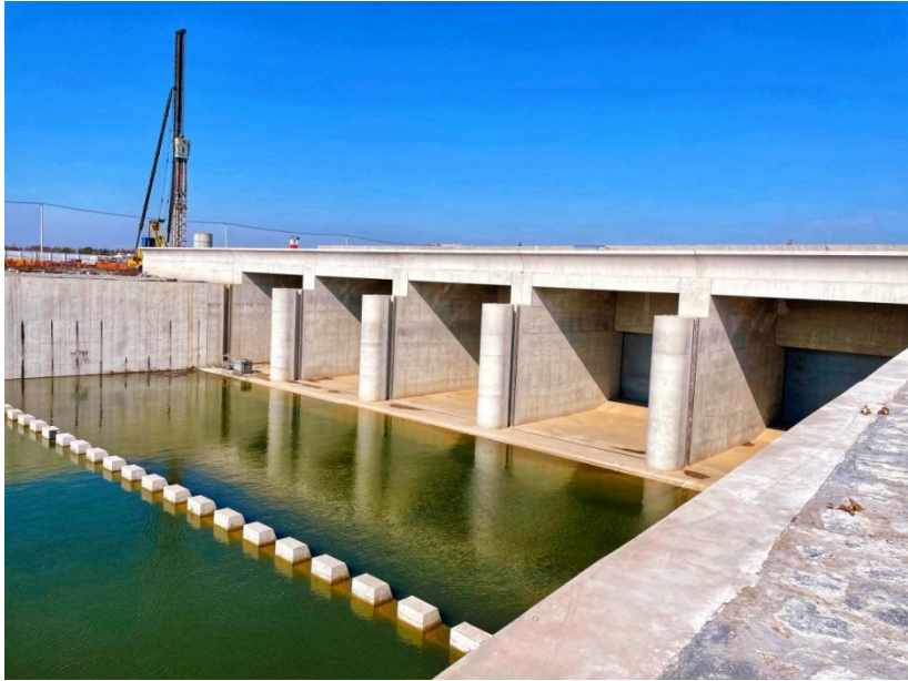
渤马河出海闸新建工程 赵盼（临港新片区管理委员会） 2021年12月1日
