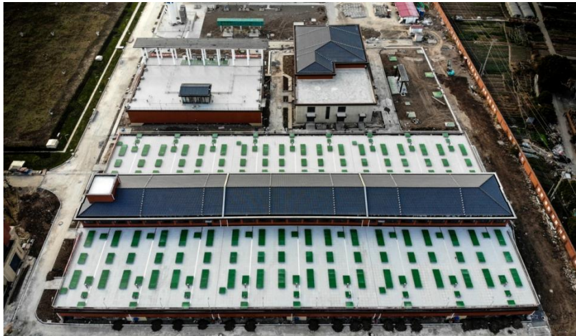
南汇南水厂深度处理工程 党政办公室 2021 年 12 月
