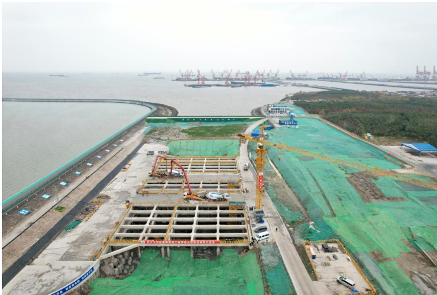
泵闸枢纽工程泵站大底板浇筑
