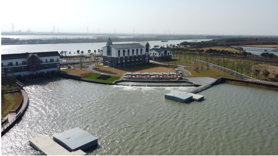
金泽水库新增取水泵站工程和跌水曝气工程 潘堃 2021年12月
