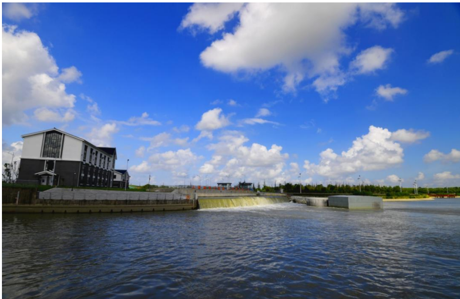
金泽水库新增取水泵站工程和跌水曝气工程 周菁 2021 年 8 月 6 日
